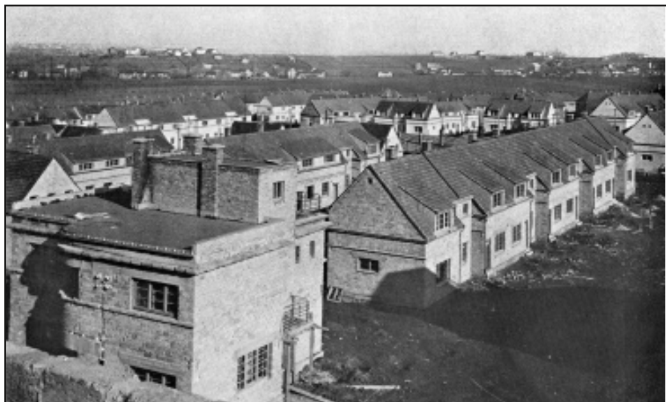
Pohled na dokončenou část I. sekce
