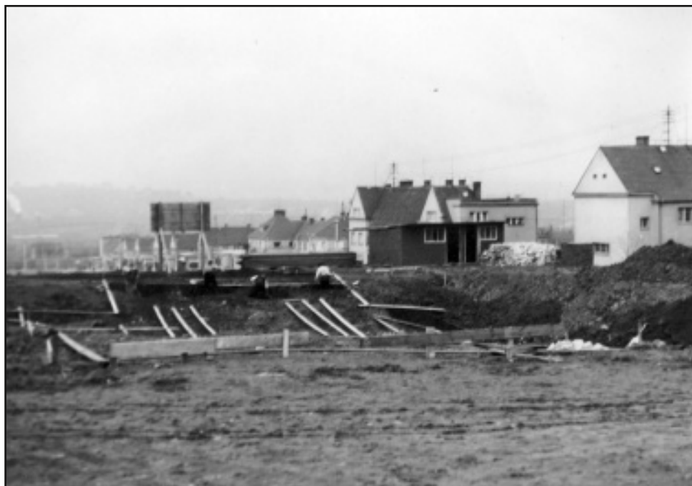
Začátek stavby kostela, 26. 3. 1935, archiv PMS
