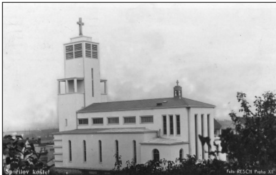
Kostel blahoslavené Anežky krátce po dokončení
